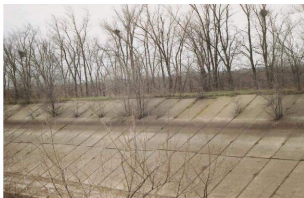
Рисунок 3. Прорастание древесных растений (вяз) в швах противофильтрационных облицовок на Большой Волгоградской оросительной системе Волгоградской области
