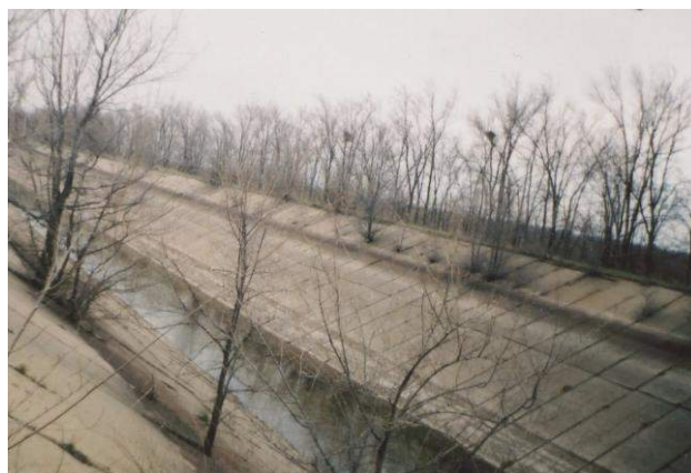
Рисунок 3. Прорастание древесных растений (вяз) в швах противофильтрационных облицовок на Большой Волгоградской оросительной системе Волгоградской области
