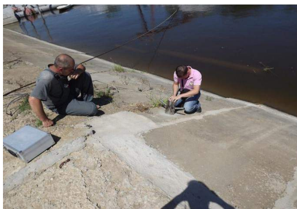
Рисунок 1. Определение водонепроницаемости бетонно-пленочной противофильтрационной облицовки на Райгородской оросительной системе
