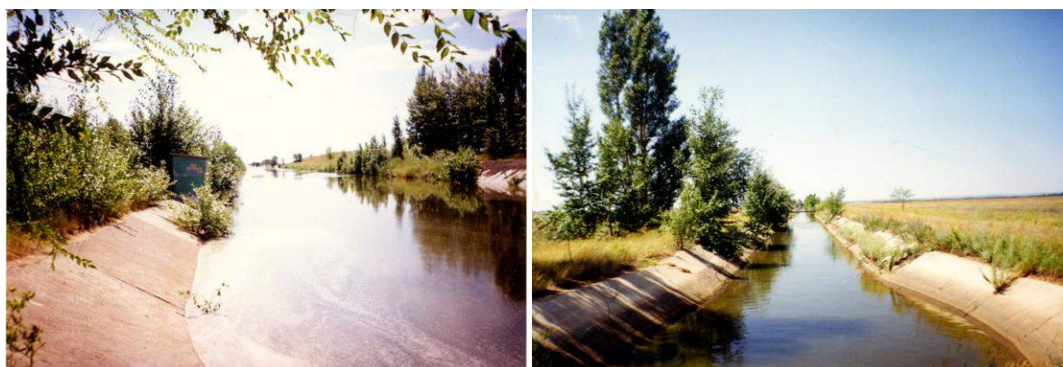
Рисунок 6. Прорастание вегетативным путем древесных и прибрежно-водных растений на бровках и в швах-стыках мелиоративных каналов Волгоградской области
